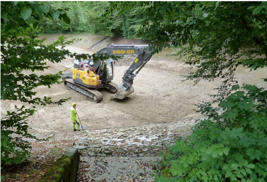
Weiher 4: Das alte Filterkies ist entfernt und die Planie bereit für den Aufbau der neuen Filterschicht.
