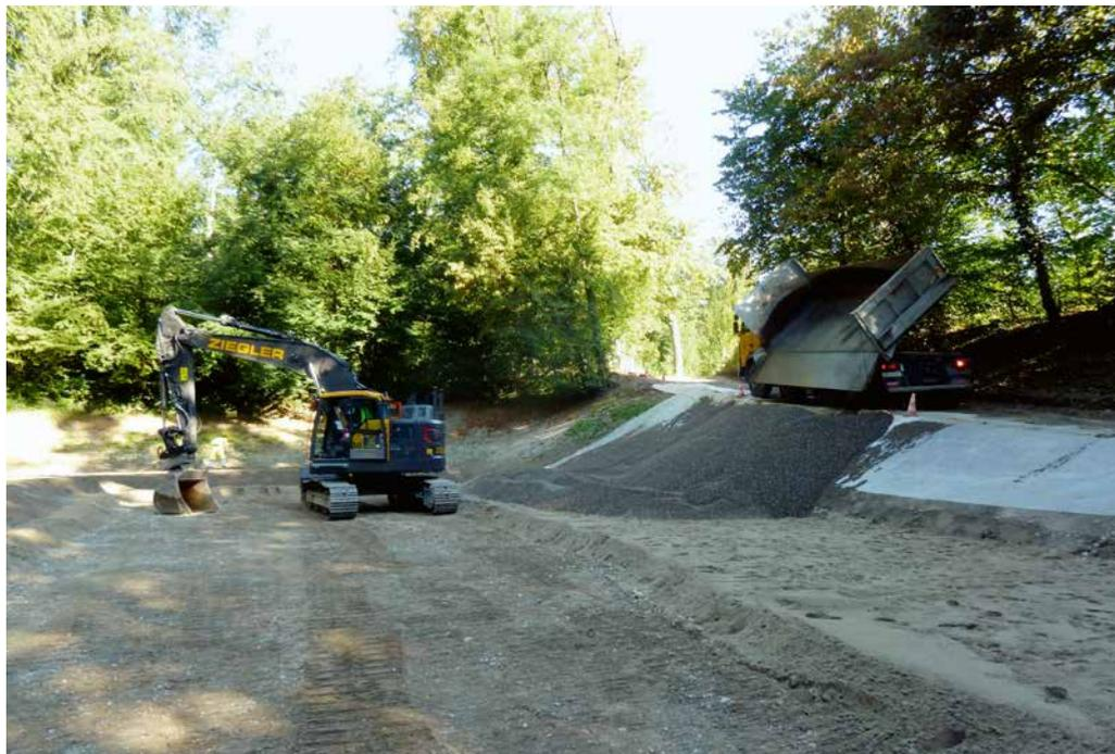
Weier 4: Aufbau der neuen Filterschicht mit Rundkies und Sand
