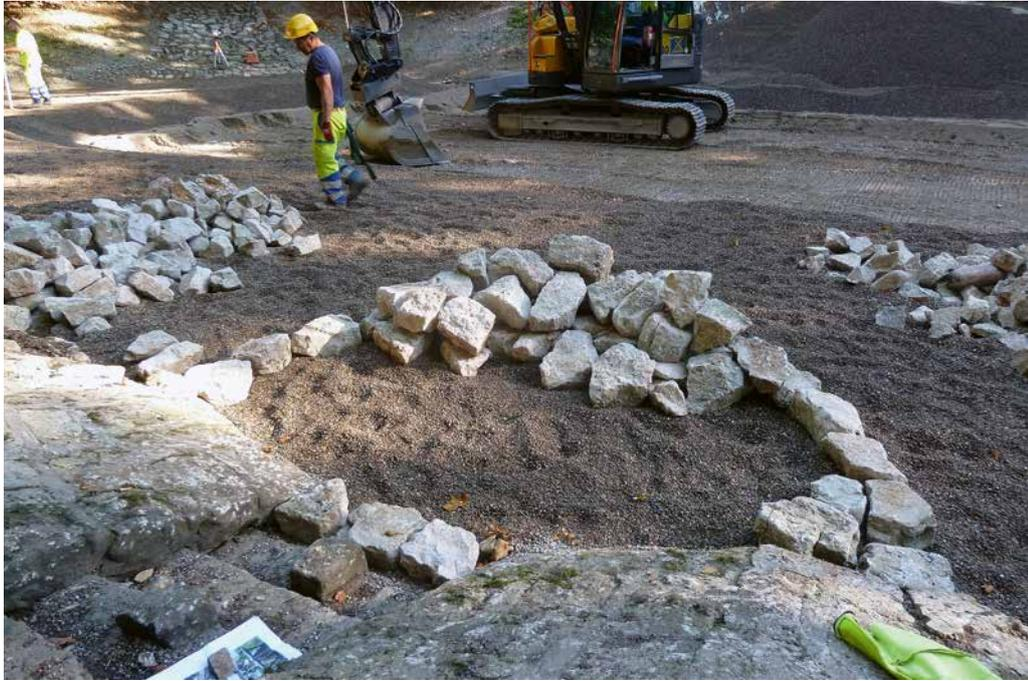
Weiher 4: Blockwurf im Einlaufbereich um eine Auskolkung der Filterschicht zu verhindern
