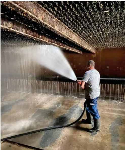
Reinigung des Absetzbeckens unterhalb der Lamellen
