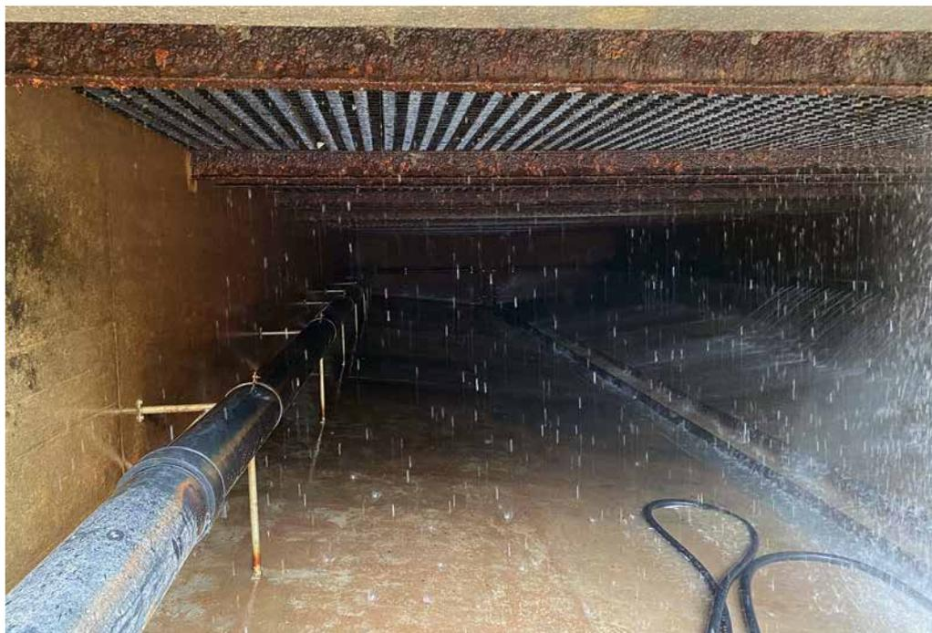
Das gereinigte Absetzbecken unterhalb der Lamellen
