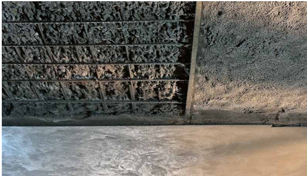
Betonsanierung der Decke im Schnellfilter 1
