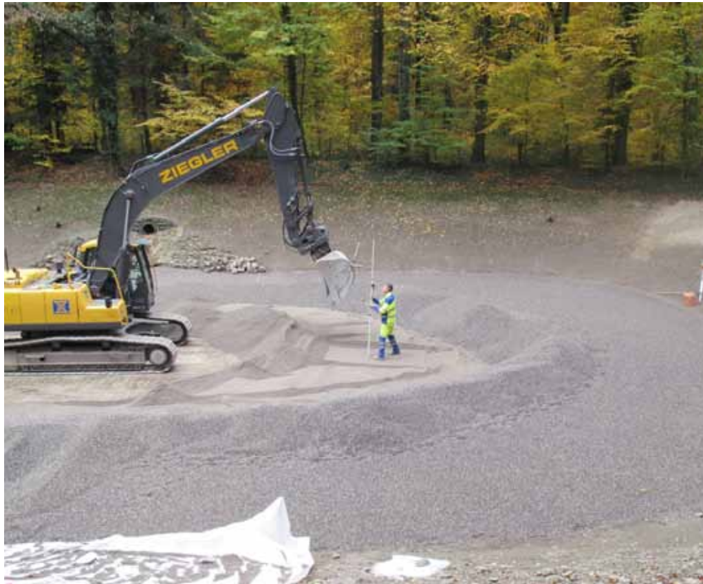
Sanierung Kiesfilter Weiher 4
