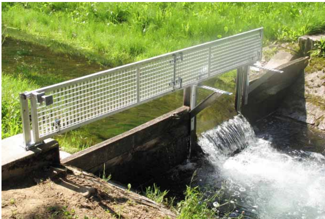
Graben A, Montage klappbarer Gitterrost
