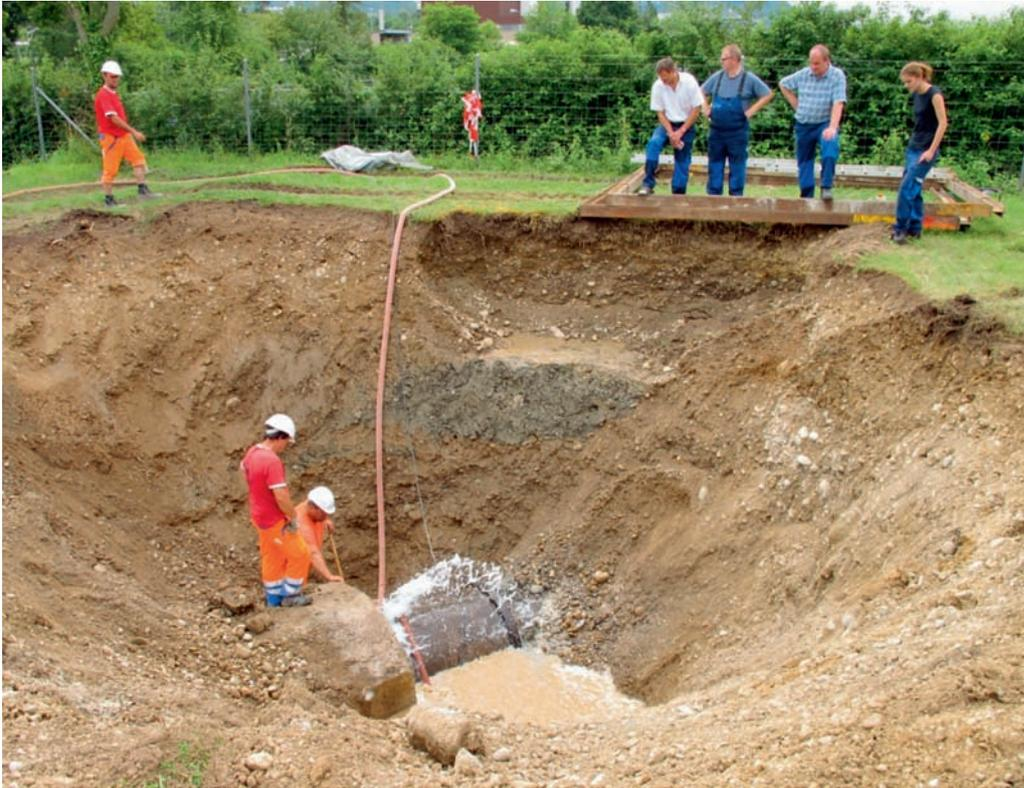
Leck in der Rohwasserleitung DN 1200 zum Absetzbecken 2
