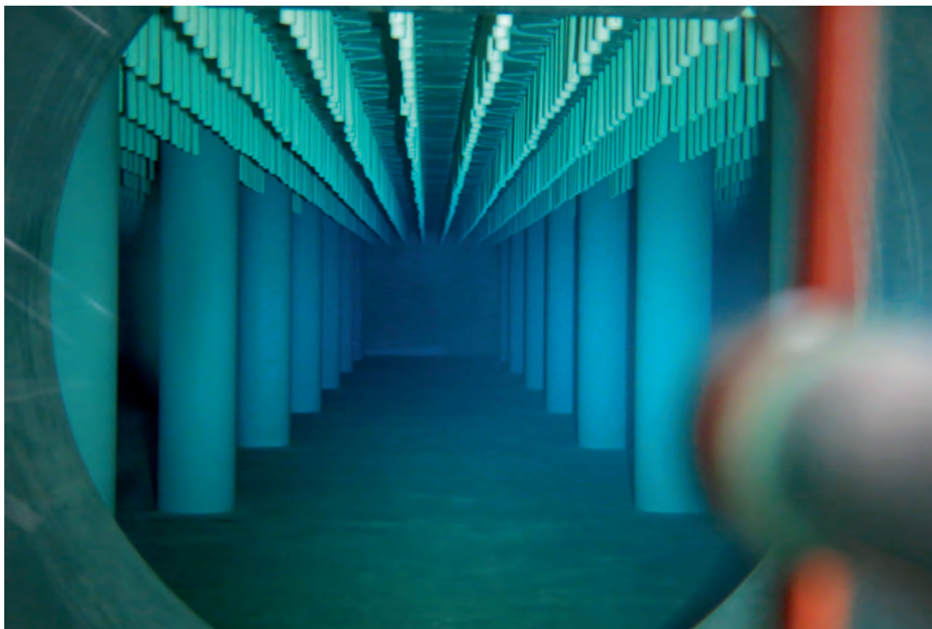
Aktivkohlefilter Hard: Einblick in die Reinwasserkammer unter dem Filterbecken
