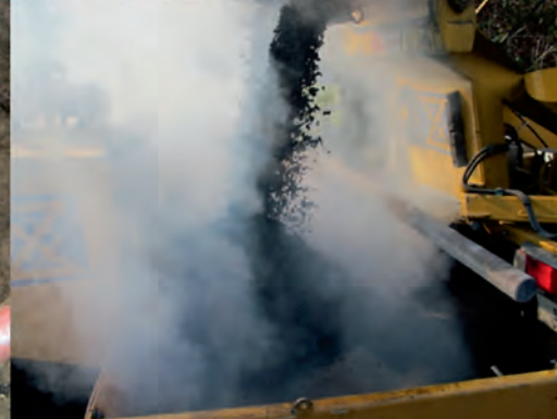
Einbringen des neuen Deckbelags
