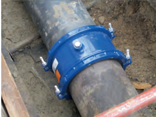
repariertes Rohrstück
