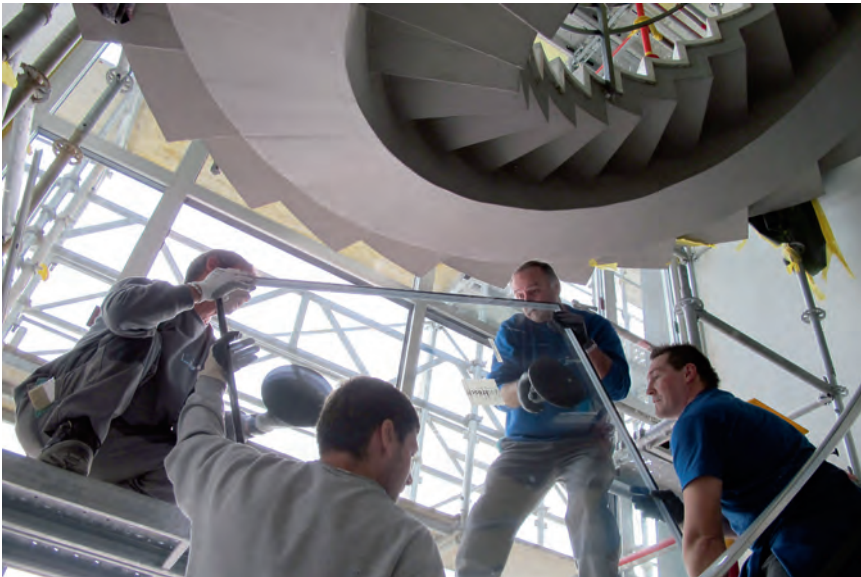
Einbau Treppenhausverglasung im Verwaltungsgebäude
