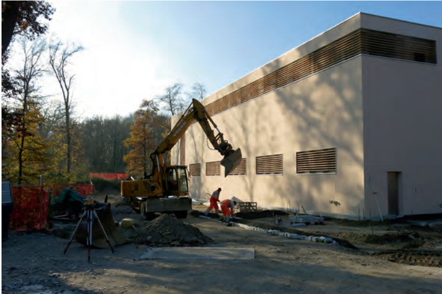
Aktivkohlefilter Hard: Umgebungsarbeiten vor der Ostfassade
