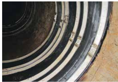
Die neuen Dichtmanschetten an den Rohrübergängen sind eingebaut
