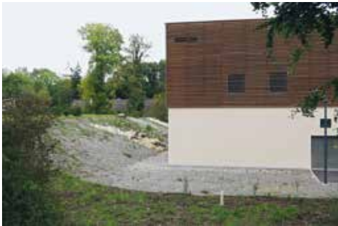
Aktivkohlefilter Hard: Südfassade mit neu gestaltetem Bord zum Reservoir
