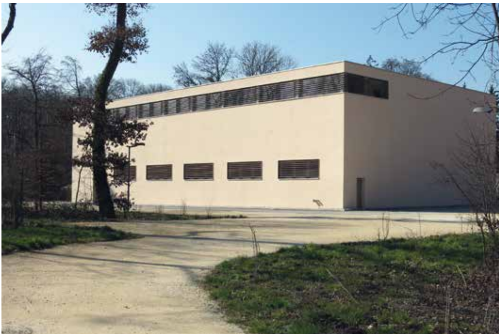
Aktivkohlefilter Hard: Blick an die Nordostecke
