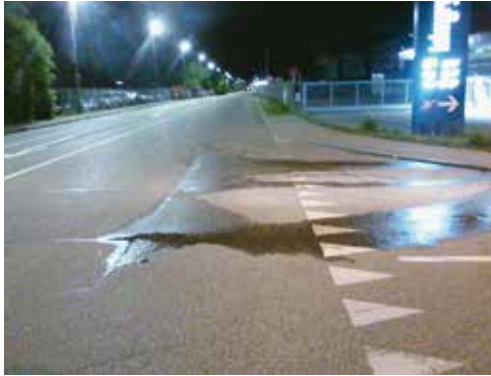
Wenig Wasser auf der Strassenoberfläche – grosse Wirkung in der Filtratleitung
