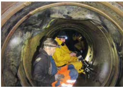
Reparatur in der Filtratleitung (Ø 1.25 m)
