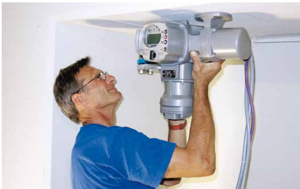
Die Montage des Steuerungskopfes für das Filtratventil macht sichtlich Freude
