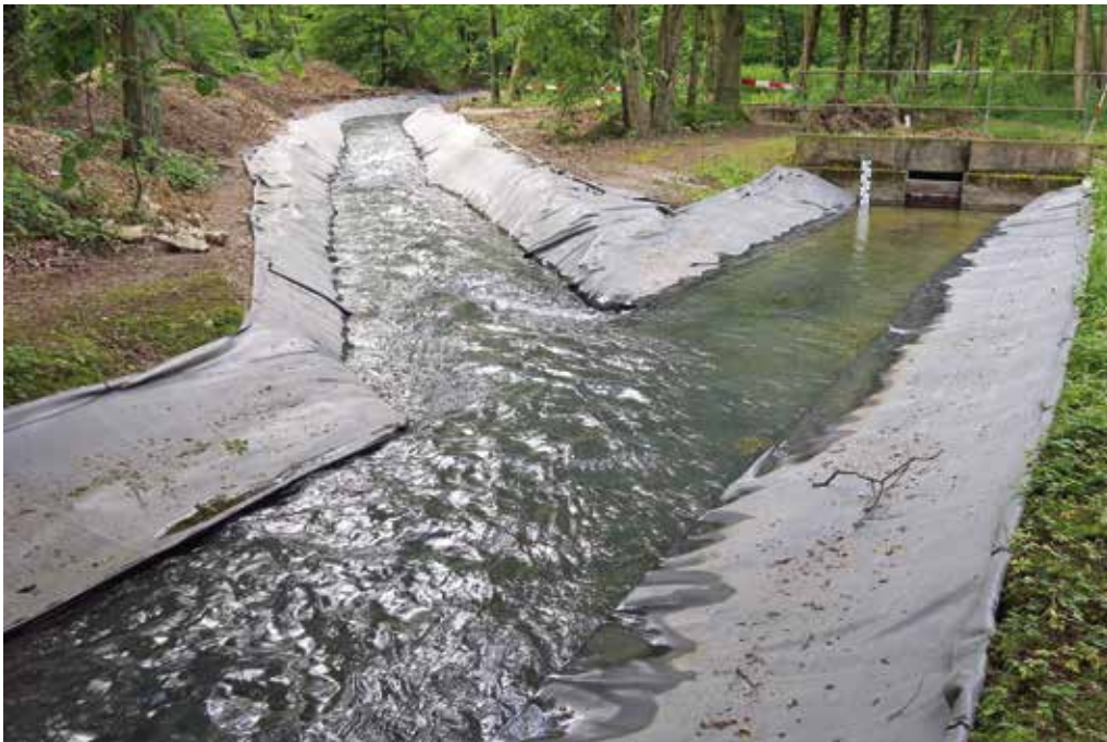
Sickergraben B, temporär als Zubringergraben umfunktioniert, mit provisorischer Umgehung
