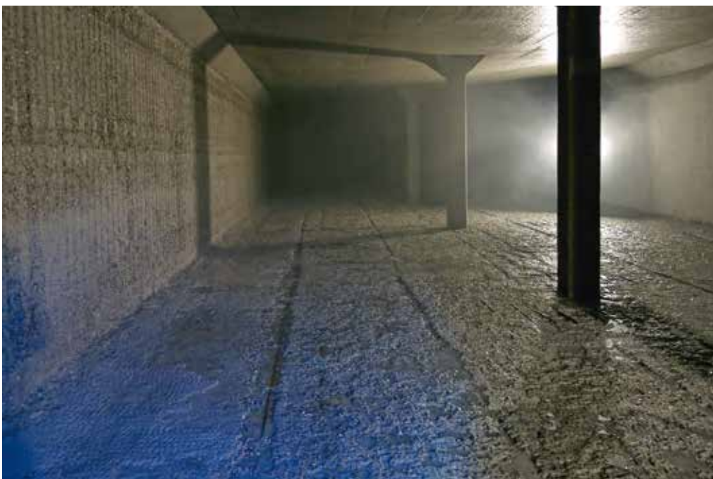
Die Reservoirkammer 1 nach dem Hochdruckwasserstrahlen und nach der Reinigung
