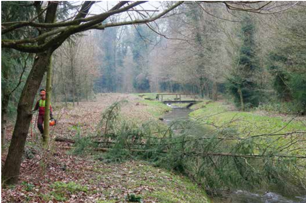
Als Vorbereitung werden die Seitenstreifen des alten Zubringergrabens gerodet.
