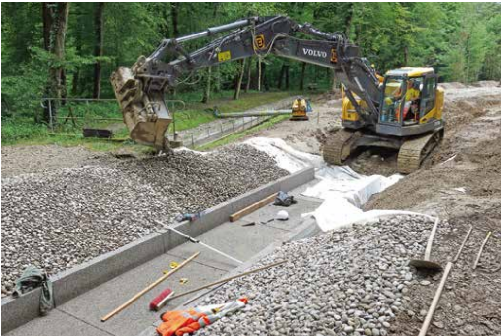
Die Erneuerungsarbeiten am Zubringergraben sind in vollem Gange
