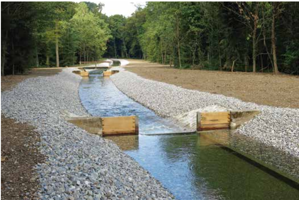
Der frisch renovierte Zubringergraben unmittelbar nach Inbetriebnahme
