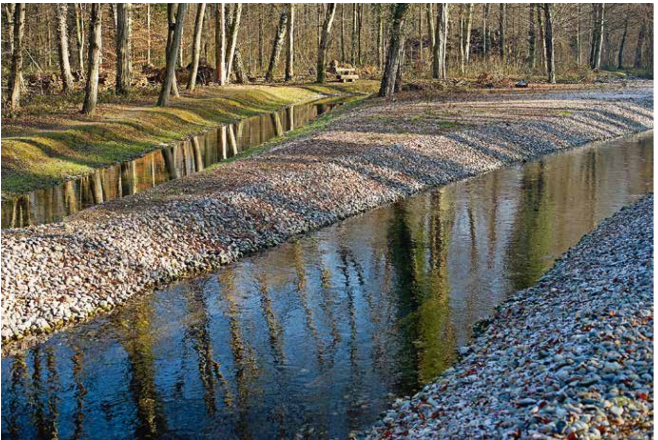
Oben: Sickergraben A, unten: der neu gestaltete Zubringergraben
