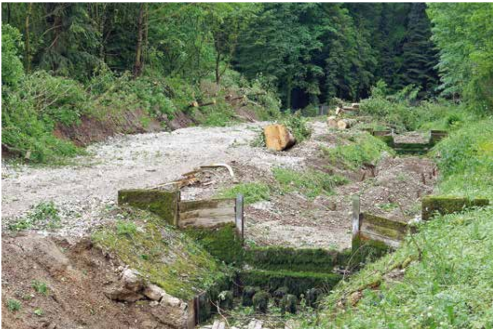
Vom alten Zubringergraben ist während des Rückbaus fast nichts mehr zu sehen
