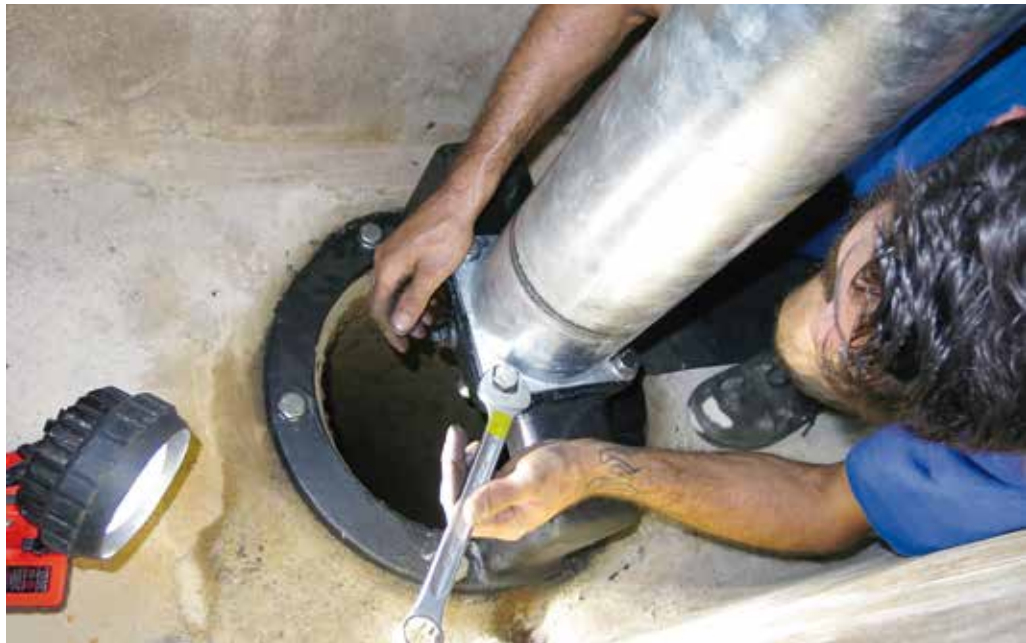
Unter engsten Verhältnissen wird im Schnellfilter 1 ein Rohwasserventil eingebaut
