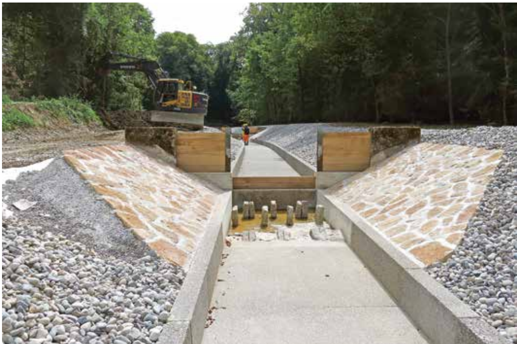
Letzte Arbeiten am Zubringergraben vor der Inbetriebnahme
