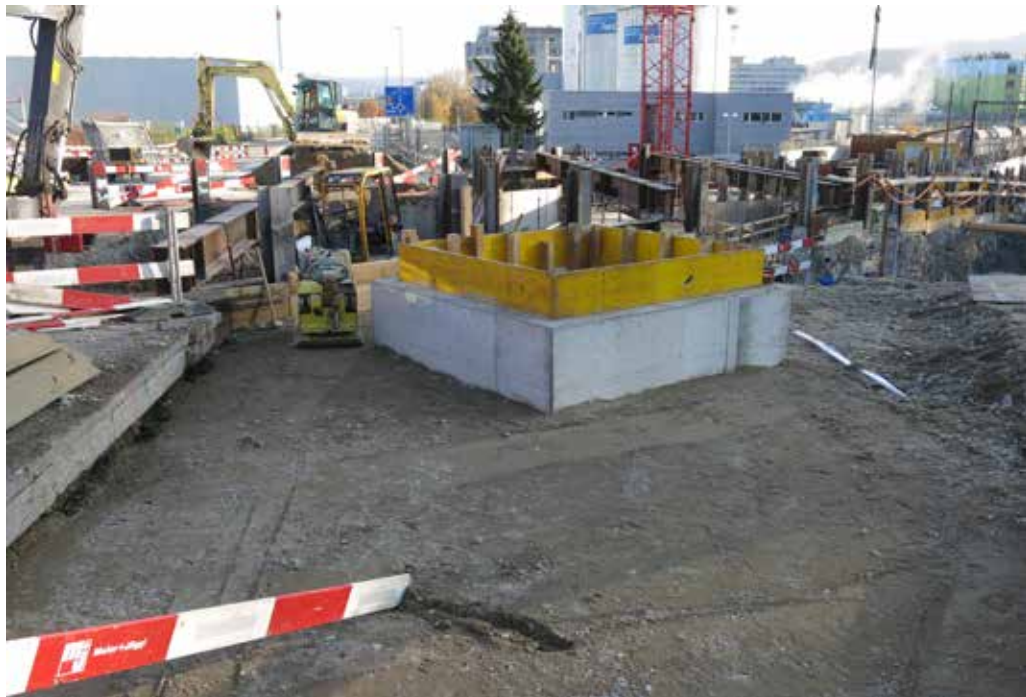
Nach Auffüllung der Baugrube bleibt der Einstiegstutzen durch einen Betonschacht zugänglich.
