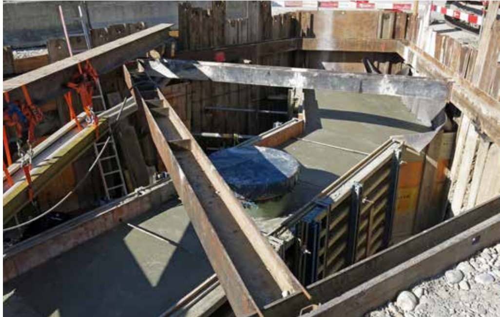
Die Filtratleitung wurde nach der Montage komplett einbetoniert. In der Mitte ist der Einstiegstutzen sichtbar.
