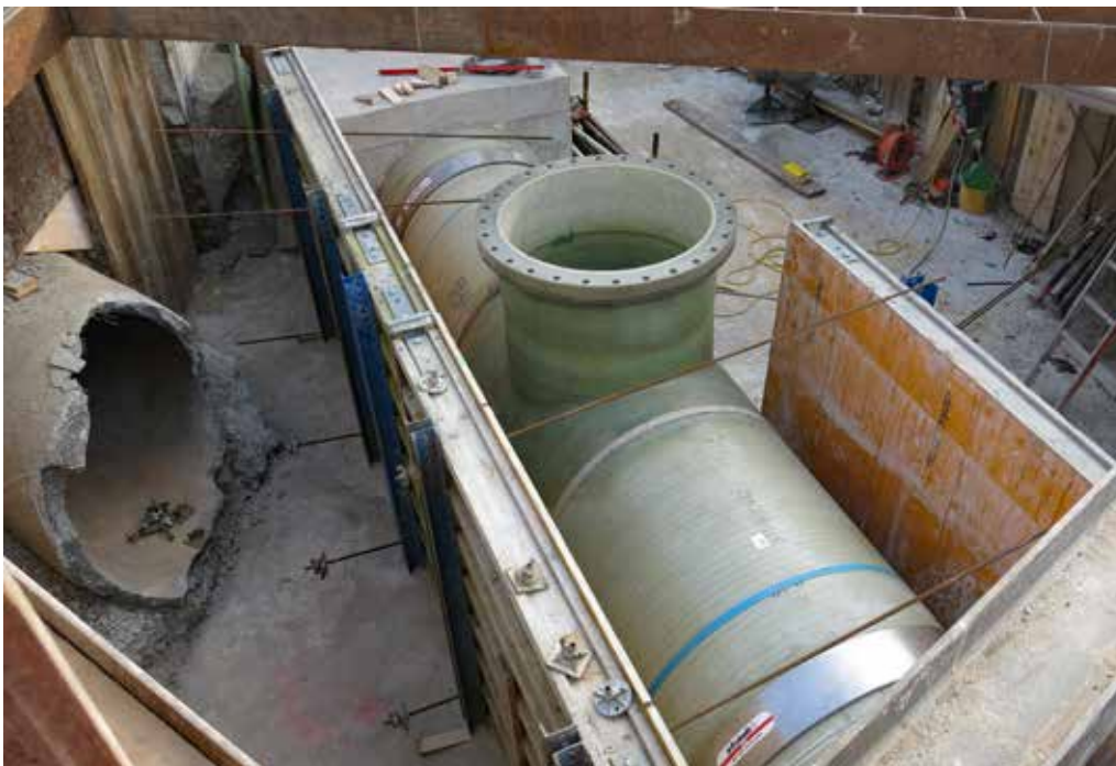
Zusammenschluss der Rohrleitung mit einem «T-Stück» als Einstiegsöffnung
