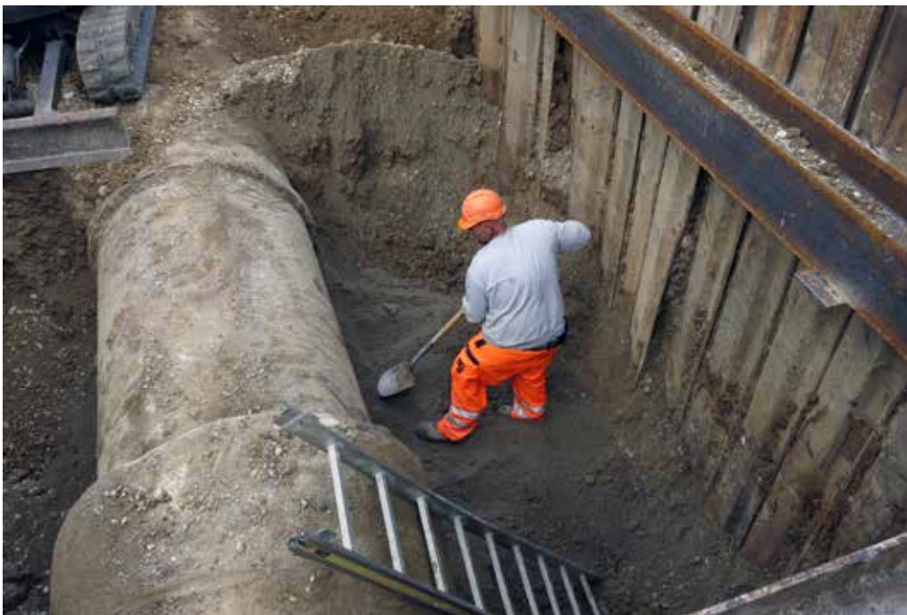
Die über sechzig Jahre alte Filtratleitung wird im Anschlussbereich an das neue Leitungstück freigelegt.
