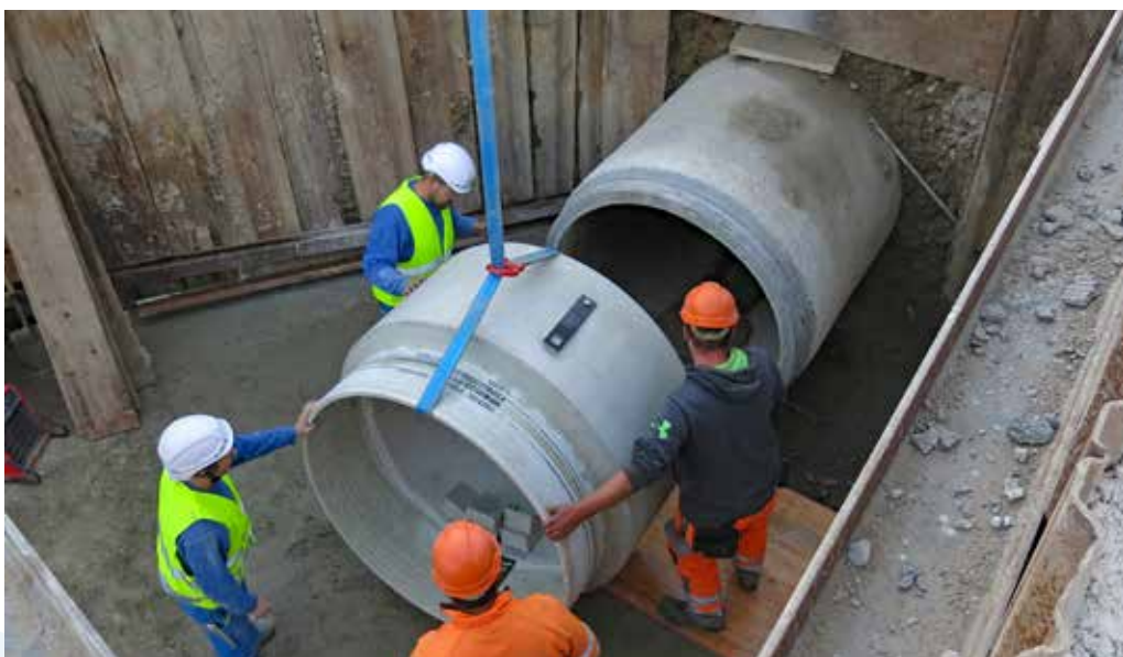
Eines der beiden Adapterstücke wird sorgfältig an die alte, sauber gereinigte Muffe des alten Betonrohres geschoben.
