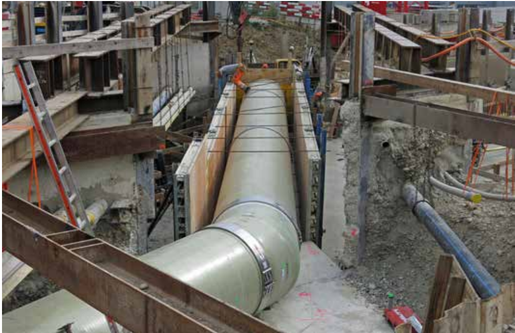
Das neue Rohrleitungsstück, welches während dem normalen Betrieb vormontiert wurde.
