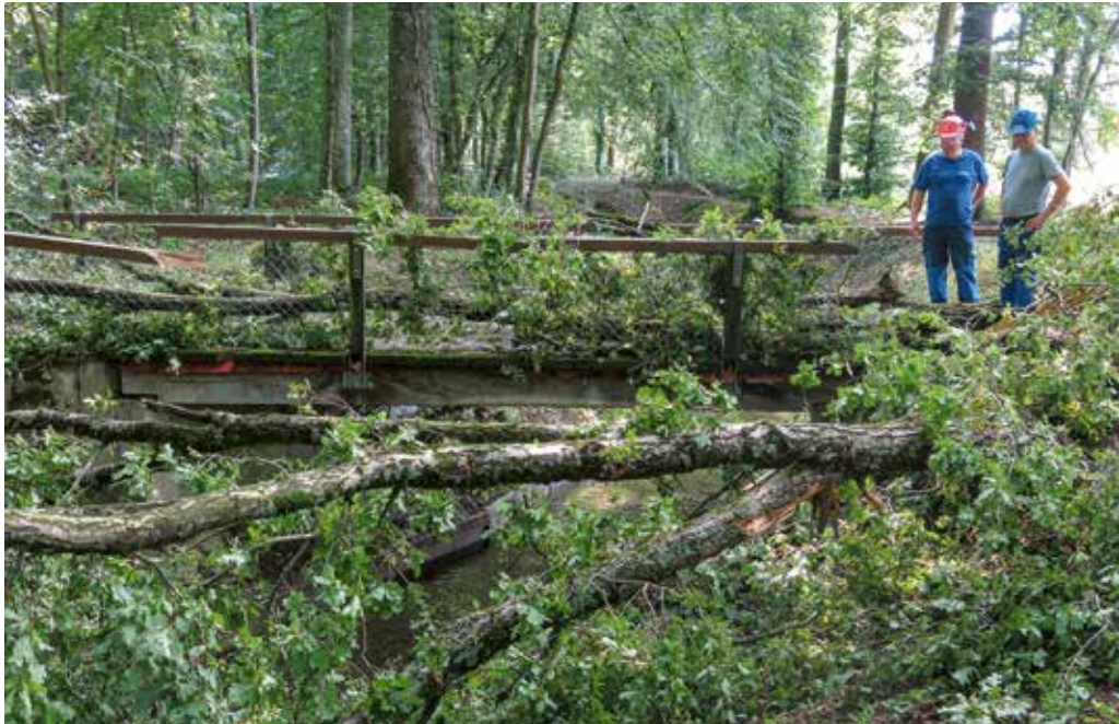
Beim Graben F hat das Sturmholz eine Brücke beschädigt.
