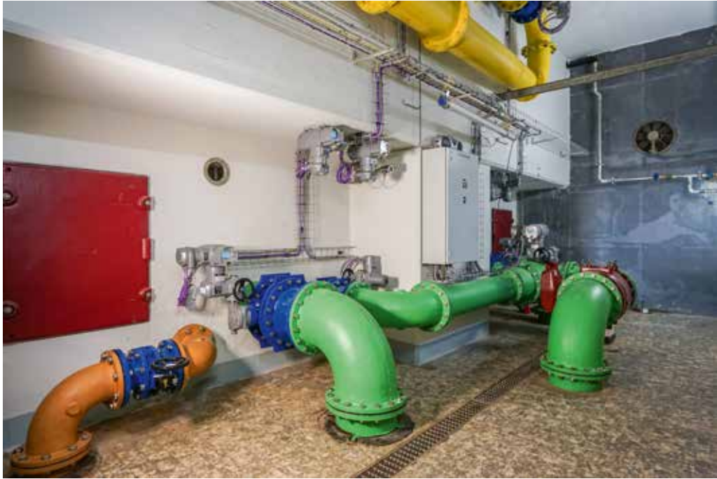
Im Rohrleitungskeller sind unterdessen alle Armaturen, Rohrleitungen und Elektroantriebe eingebaut...
