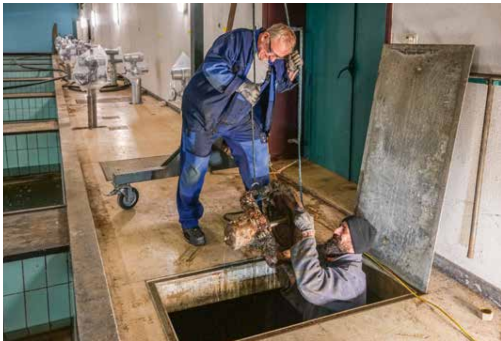
Alte Unterwasserventile werden zur vollständigen Restaurierung demontiert – Freude herrscht.
