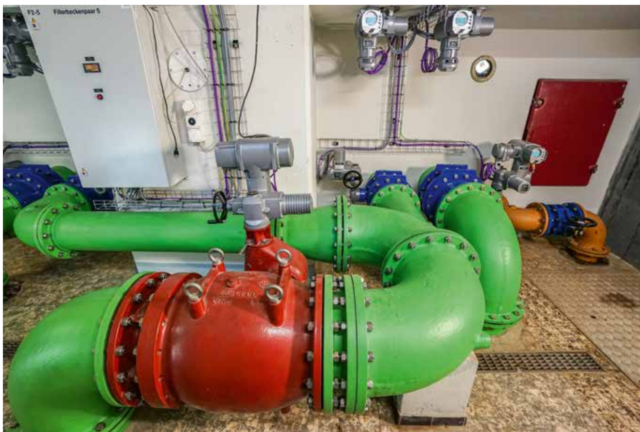
Rohrleitungskeller Schnellfilter F02 nach dem Umbau
