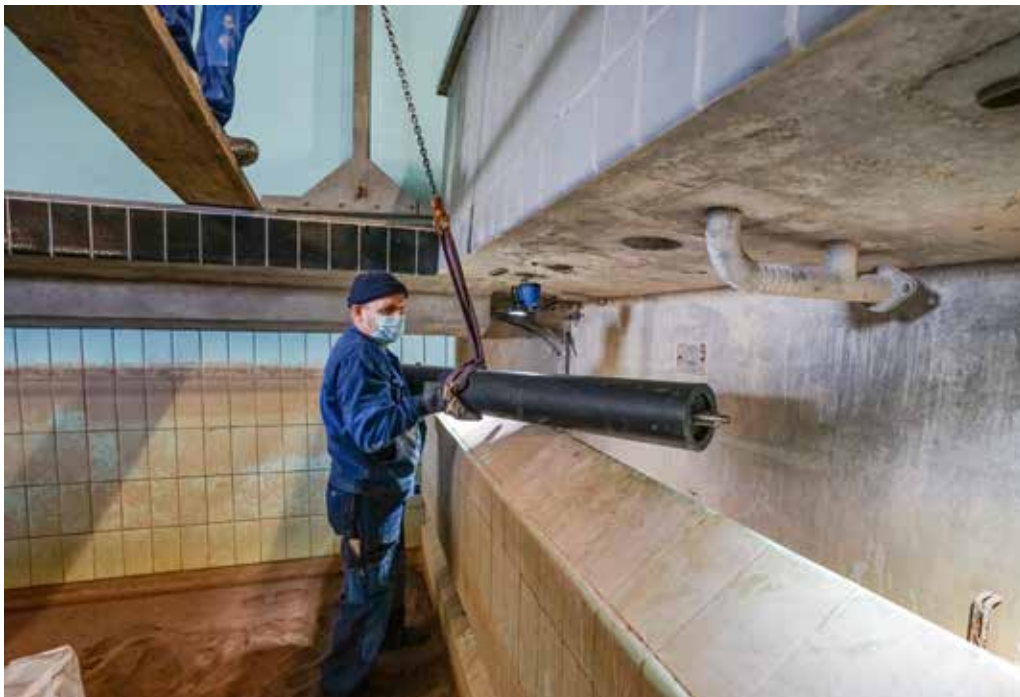
Die gummierte Verschlusswalze wird in den Schlammwasserschacht eingeführt.
