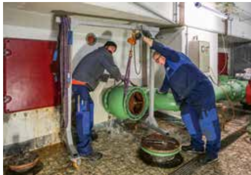
Bei der Demontage der ausgebrauchten Armaturen wird es auch mal nass. Samuel Müller und Beat Stürchler nehmen das aber gelassen.
