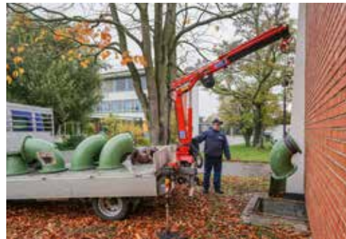
Die noch gebrauchsfähigen Rohrbogen werden abtransportiert und aufgefrischt.
