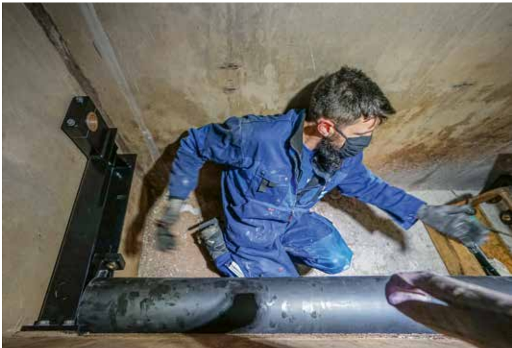
Die gummierte Verschlusswalze wird durch Samuel Müller in die korrekte Position gebracht.
