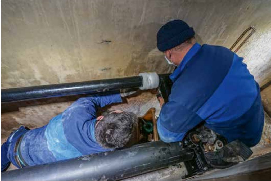
Weitere Bauteile werden in engsten Verhältnissen im Schlammwasserschacht gemeinsam verbaut.
