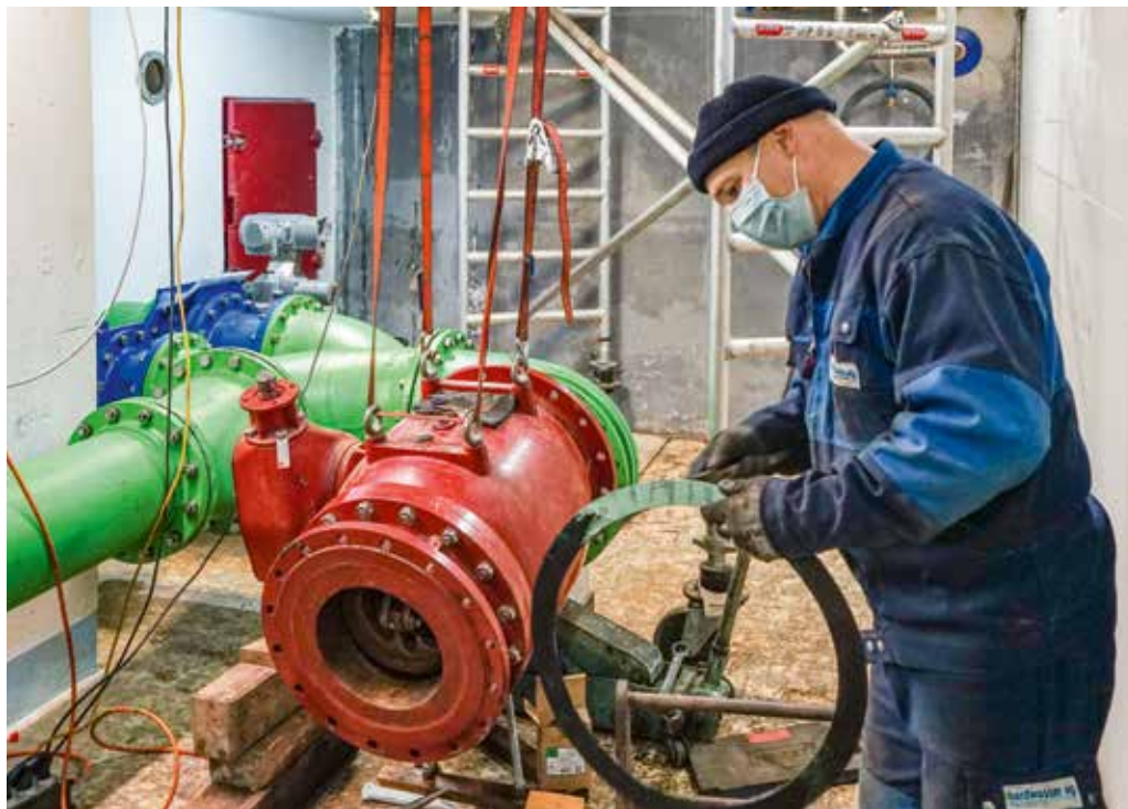
Konzentriert bereitet Robert Seiler eine neue Flachdichtung zur Montage vor.
