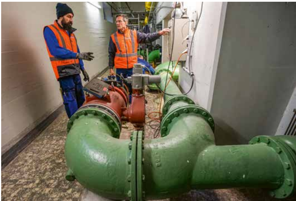
Samuel Müller und Heinz Stauffer besprechen die Demontage der alten Rohrleitungen zu einer Zeit als noch keine Maskenpflicht verordnet war.
