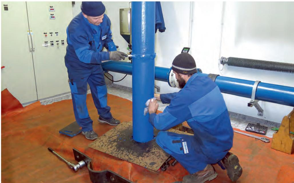
Der Farbanstrich der revidierten Bohrlochpumpe wird ausgebessert
