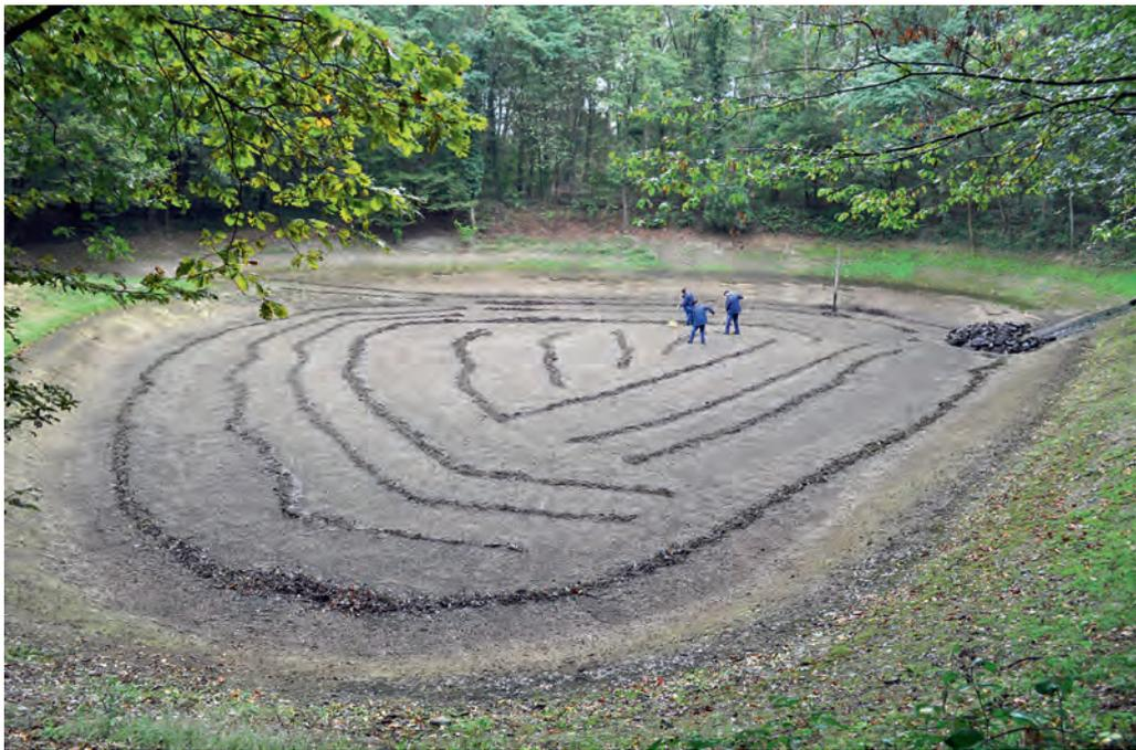
Reinigung der Filterkiessohle in Sickerweiher 6
