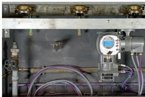
Nach dem Umbau des Schnellfilters: Antriebstechnik mit elektronischen Steuereinheiten
